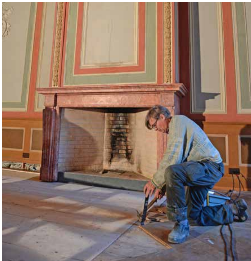
Mit Hammer und Stemmeisen löst Holzfachmann Beat Kuonen die beschädigten Stücke aus dem Parkettboden heraus.
